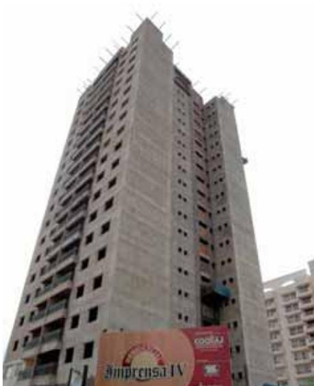
Serviços iniciados em janeiro: pintura interna dos apartamentos, instalação de cerâmica e rejunte de cozinhas e banheiros, instalações elétricas, hidráulicas e reboco interno do térreo.
